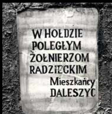
Tablica z inskrypcją na „pomniku wdzięczności” w Daleszycach (widoczne pęknięcia). Zbiory: Instytutu Pamięci Narodowej.
