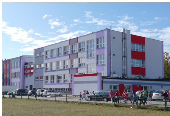
Budynek Zespołu Szkół w Kostomłotach Drugich przed rozpoczęciem i po zakończeniu prac termomodernizacyjnych
