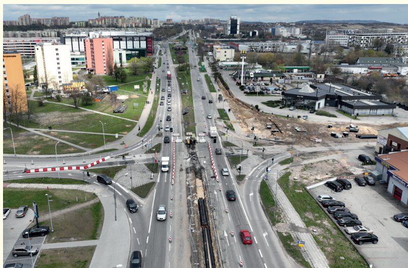
Trwa remont na al. Solidarności. Równolegle z pracami wykonywanymi przez drogowców, na zlecenie Miejskiego Przedsiębiorstwa Energetyki Ciepłej budowana jest nowa sieć DN300.
