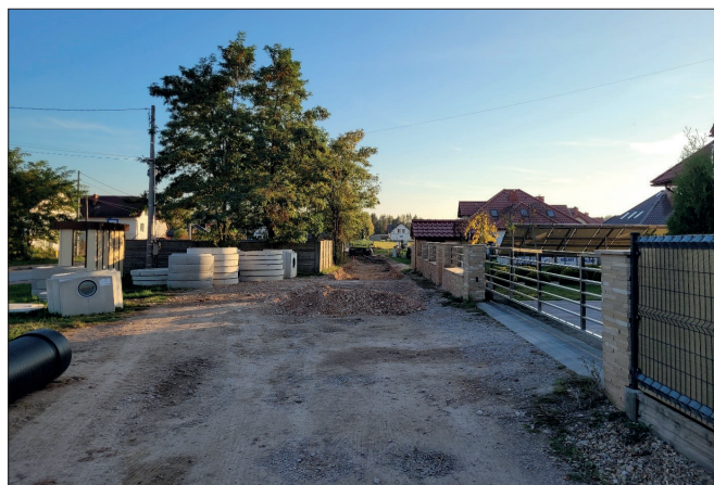
Trwają prace budowlane na ulicy Kryształowej w Kowali.
