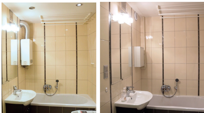
Łazienka przed zmianą instalacji i po niej.
