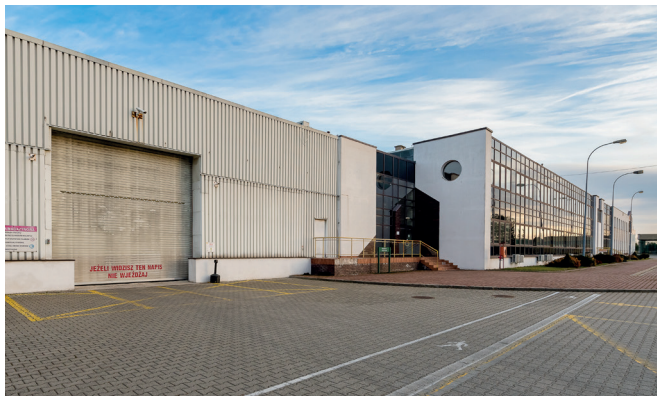
Budynek posiada również powiązaną funkcjonalnie przyległą bezpośrednio część administracyjno-biurową. Budynek magazynowo - biurowy posiada następujące instalacje techniczne: m.in. gazową (gaz ziemny), elektryczną i odgromową, kominową, wodno-kanalizacyjną oraz centralnego ogrzewania z piecem gazowym o mocy 1120 kW.
