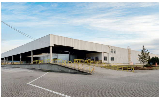
Na całej szerokości od strony zachodniej przy magazynie znajduje się rampa zewnętrzna do załadunku i wyładunków towarów. Rampa zewnętrzna w większości jest zadaszona. W środkowej strefie magazynu znajduje się wewnętrzna rampa rozładunkowa przeznaczona na wjazd samochodów transportowych.
